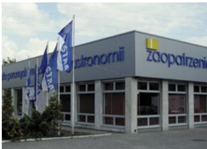
Fot. 3. Nowa siedziba firmy w Chorzowie
